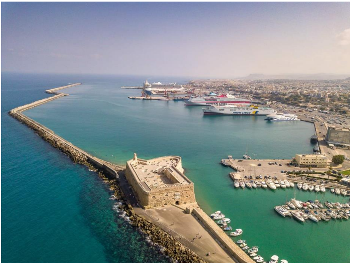
Εικόνα 16. Πανοραμική εικόνα του Λιμενοβραχίονα στο Λιμάνι του Ηρακλείου (Πηγή: https://porthera.klion.gr/index.php/el/ )
